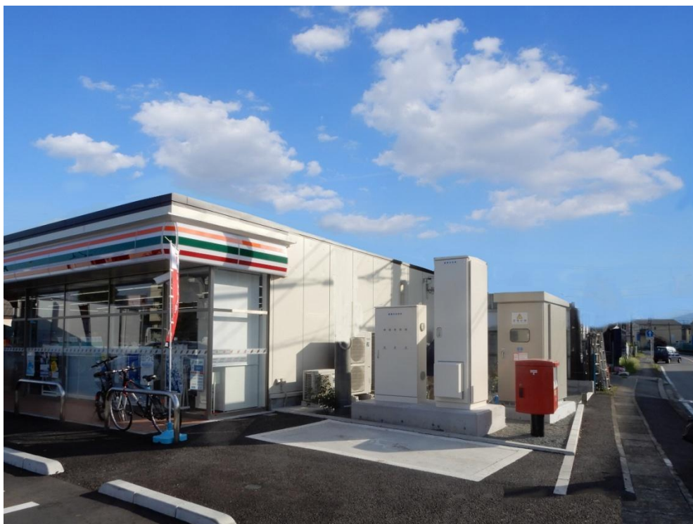
太陽光パネル 19kW、蓄電池容量 40kWh
