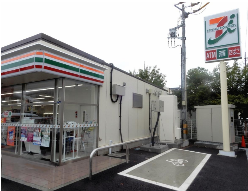
太陽光パネル 19kW、蓄電池容量 40kWh
