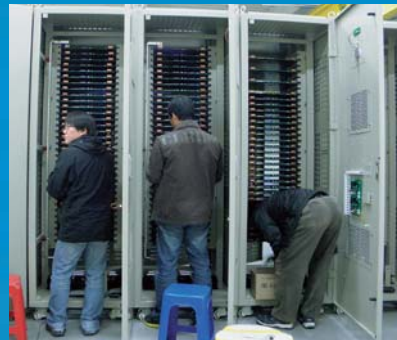
上記写真は25Kwh電池ラック×8Set＝200Kwhシステムです
